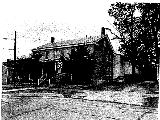
Exterior - NE Corner
