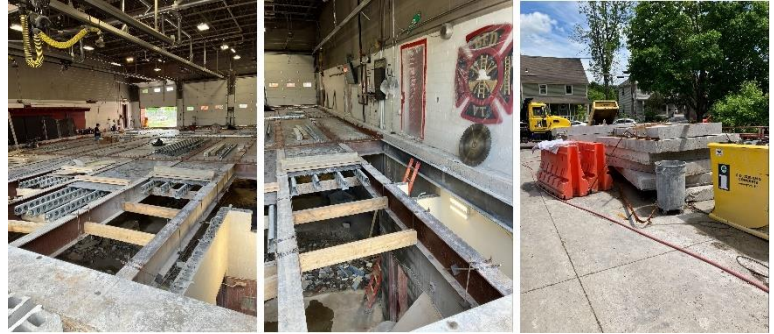
Fire Station 2 floor, ready to pour
